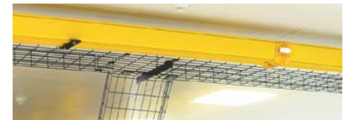
Installation typique d'un cheminement suspendu avec des supports fixés au plafond
